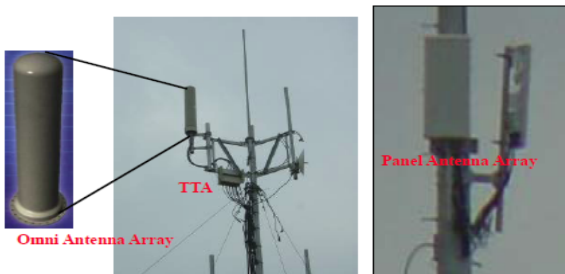
Рисунок 7.1. Всенаправленная антенна, панельная антенная решетка и мачтовый усилитель
